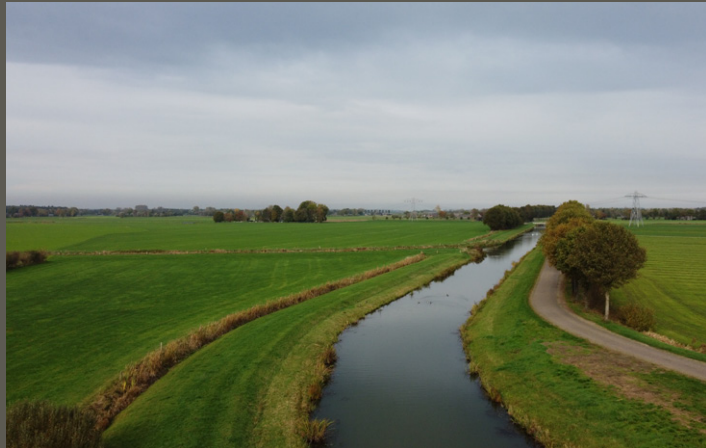
Afb. 4.3 De weteringen en vloedgraven werden gegraven om het natte, beekloze Salland te ontwateren.
