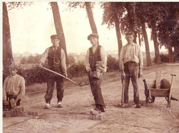
Afb. 3.36 De aanleg van de Zuiderzeestraatweg.
